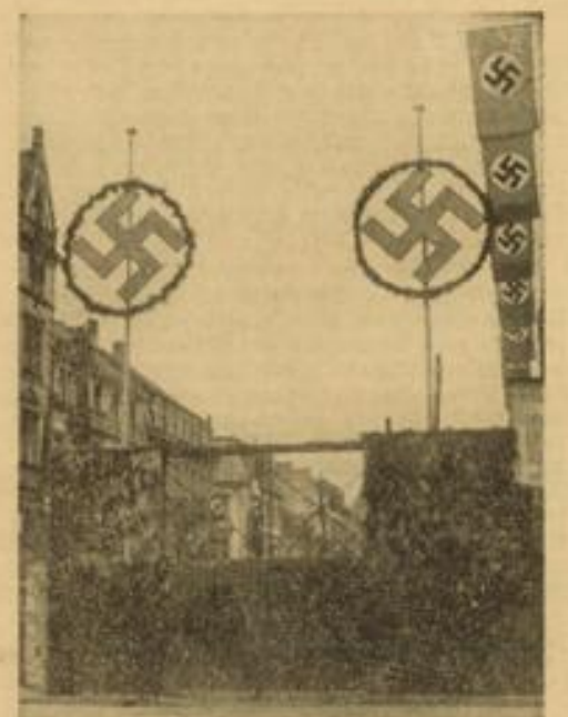
Selbst die Baustelle des neuen Technischen Rathauses hatte diesmal Festschmuck angelegt. Der Bretterzaun war mit Tannenzweigen verkleidet und von dem neuen Gebäude wehten erstmals die Fahnen in langer Reihe.
