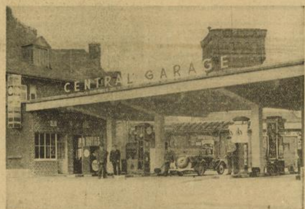
Eine Tankstelle, die neuzeitlichen Ansprüchen genügt
