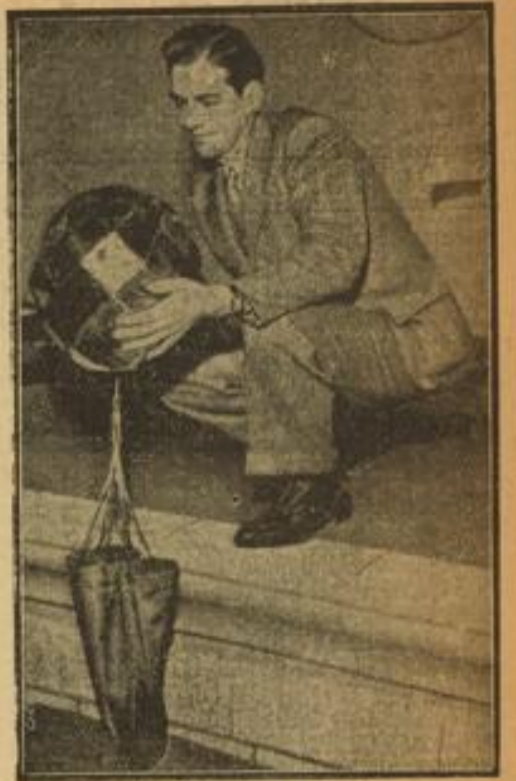
Reflexkugel als Notsignal für Wasserflugzeuge Ein amerikanischer Erfinder aus San Francisco konstruierte eine Kugel aus Leichtmetall, deren Oberflächen die Lichtstrahlen besonders gut reflektieren. Diese Einrichtung soll als Notsignal für Wasserflugzeuge dienen, die auf den langen Ozeanstrecken notlanden müssen. Durch die starke Lichtreflexion wird den Scheinwerfern der Hilfsschiffe die Suchaktion nach dem Flugzeug erleichtert. Der Gummisack, der unter der Kugel hängt, kann außerdem aufgeblasen und als Rettungsball verwendet werden. (Scherl-Bilderdienst-M)
