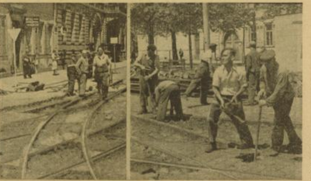
Die Auswechslung der Straßenbahnleise und der großen Dreiecksweiche am Schloß macht eine mehrtägige Verkehrsumleitung erforderlich, während — wie aus nebenstehendem Bericht hervorgeht — die Einschränkungen für den Straßenbahnbetrieb lediglich am Donnerstag bestehen. Unsere Bilder zeigen die Vorbereitungsarbeiten für die Gleiserneuerung. Aufn.: H. Jütte (2)
