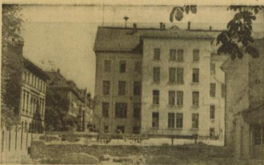
Nachdem die Abbrucharbeiten im N-6-Quadrat soweit vorgeschritten sind, daß jetzt an der Rückseite der Ingenieurschule die letzten Mauerreste der dort niedergelegten Häuser abgetragen werden können, ist auch der volle Blick auf die rückwärtige Fassade der Ingenieurschule frei geworden. Bisher machten die hohen Häuser mit den engen Höfen diesen Ausblick vollkommen unmöglich. Aufn.: Hans Jütte
