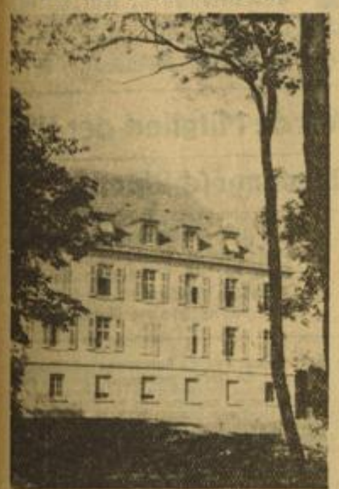
Ein Blick vom Garten des Städtischen Krankenhauses auf das neue, jetzt fertiggestellte Arztwohnhaus. Aufn.: Hans Jütte
