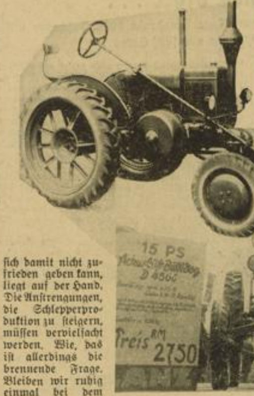
Das war die Lanz-Ueberraschung in Leipzig. Der 15-PS-Akerluft-Bulldog mit 6 Fahrgeschwindigkeiten, elektr. Beleuchtung, Anlasser und Zapfwelle.
