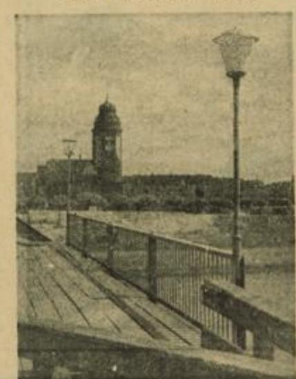
An der Ostseite der Friedrichsbrücke wurde ein Teil des neuen Gehweges in der künftigen Breite angebaut; man erprobte dabei auch die Wirkung der neuen Beleuchtungskörper, die inzwischen wieder entfernt wurden. Aufnahme: Jütte
