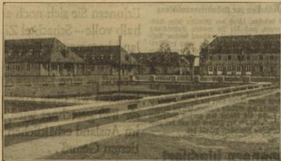
Vorbildliche Helme im Vorwerk Braunschweig. Im Vorwerk Braunschweig, einem Teil des Volkswagenwerkes, sind vorbildlich eingerichtete Helme entstanden.
