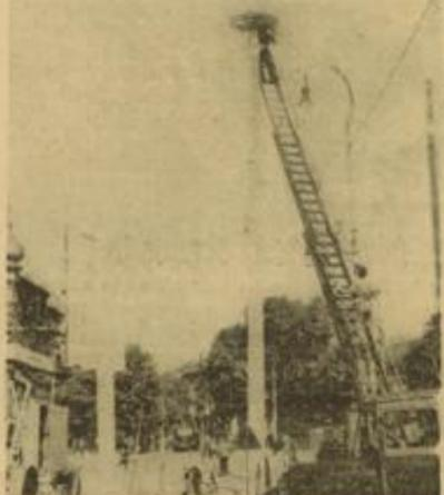
An dem stadtseitigen Brückenkopf der Friedruchsbrücke sind nunmehr alle neuen Masten aufgestellt. Man ist bereits dazu übergegangen, an den Masten die Beleuchtungskörper anzubringen...
