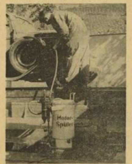
Dieser Apparat jagt das Spüliöl mit hohem Druck in ständigem Kreislauf durch den Motor und holt sämtlichen Schmutz heraus.
