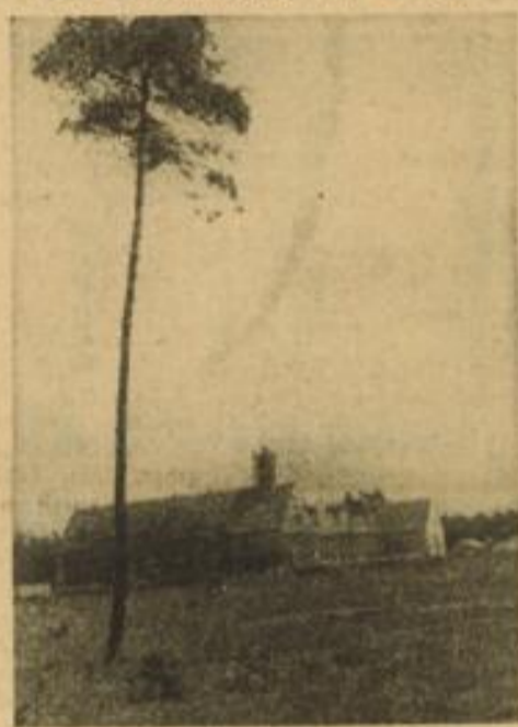
In der Schönan-Siedlung geht ein stattliches Gebäude seiner Fertigstellung entgegen, das längst zum dringenden Bedürfnis gewordene Schulhaus für die kräftig angewachsene Siedlung. Aufn.: Jütte
