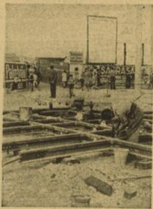
Das ist das neue Herzstück der Kreuzung an dem stadtsseitigen Brückenkopf der Friedrichsbrücke. Aufn.: (3) H. Jütte
