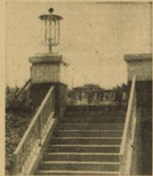
Der Zugang zum Untergeschoss mit einem der neuzeitlichen Beleuchtungskörper.
