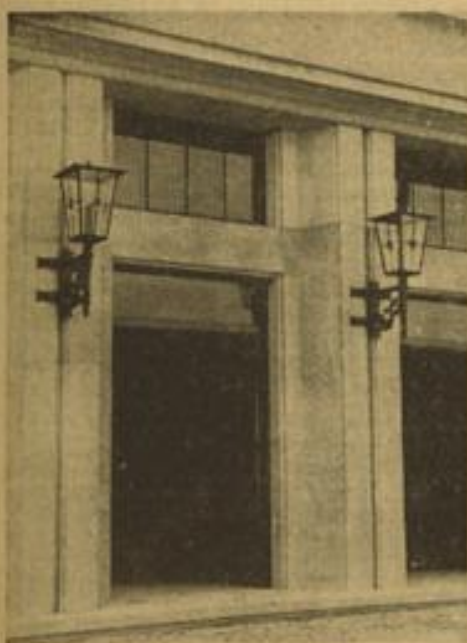
Der Eingang zum Wirtschaftsgebäude
