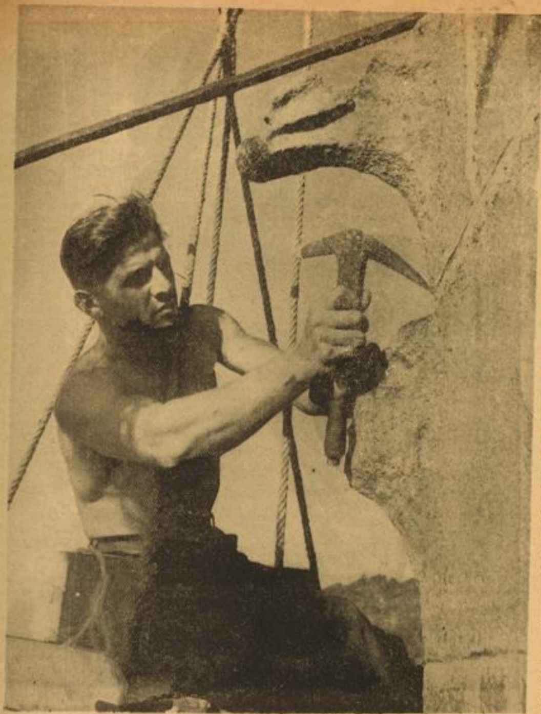
Arbeit am Turm
