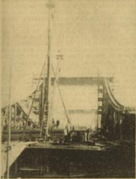
Das neue „Gesicht“ der Friedrichsbrücke, nachdem die neuen Querriegel eingebaut wurden. (Aufn.: Jütte)
