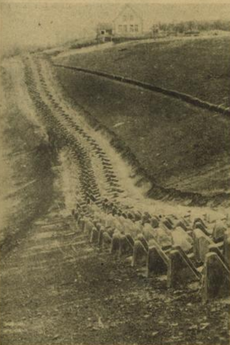
Unüberwindbar für jeden feindlichen Tankangriff ziehen sich in vielfacher Staffellager die breiten Bänder der Höckerhindernisse durch die Landschaft. (Scherl Bilderdienst)
