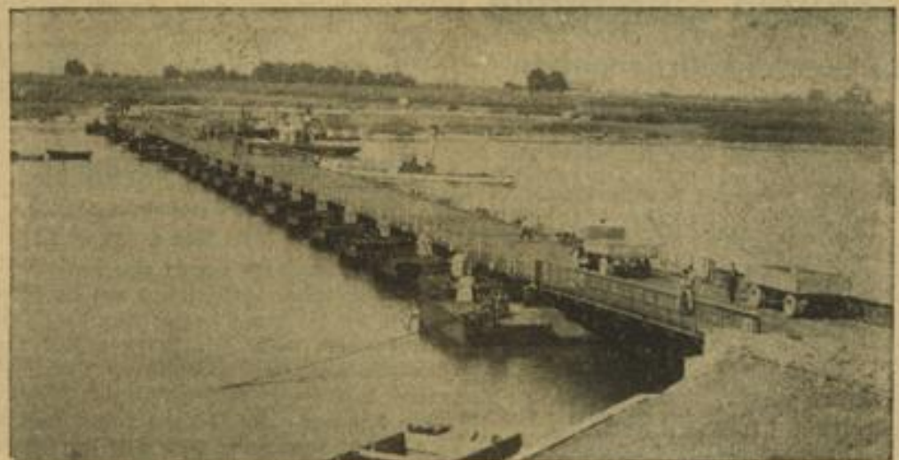
Um den von Jahr zu Jahr zunehmenden Schwierigkeiten beim Weichselübergang von Danzig nach Ostpreußen abzuwehren, wurde oberhalb der Fährstellen bei Rothebude-Käsemark eine aus 24 Pontons bestehende Brücke gebaut. Die beiden mittelsten Brückenglieder können ausgefahren werden. Die Brücke kann auch von schwersten Fahrzeugen benutzt werden. Für später ist in unmittelbarer Nähe eine feste Hängebrücke geplant. (Scherl-Bilderdienst-M.)
