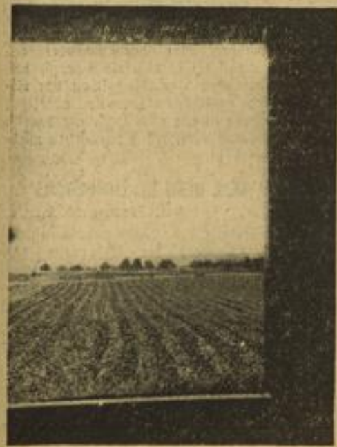
Blick aus einem Panzerwerk
