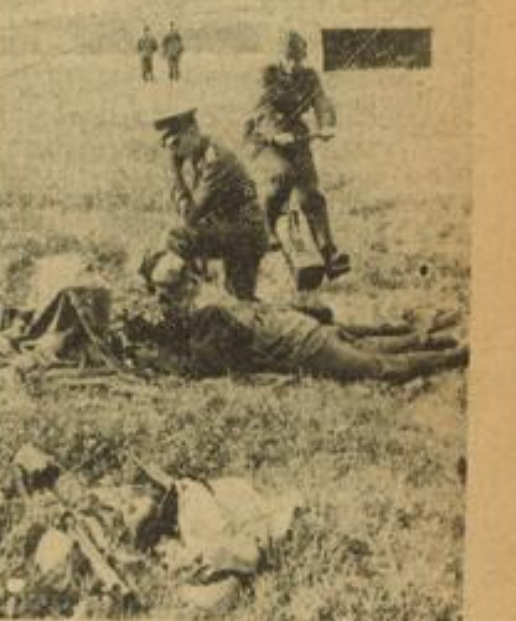
Stromerzeugung für Funkstelle
