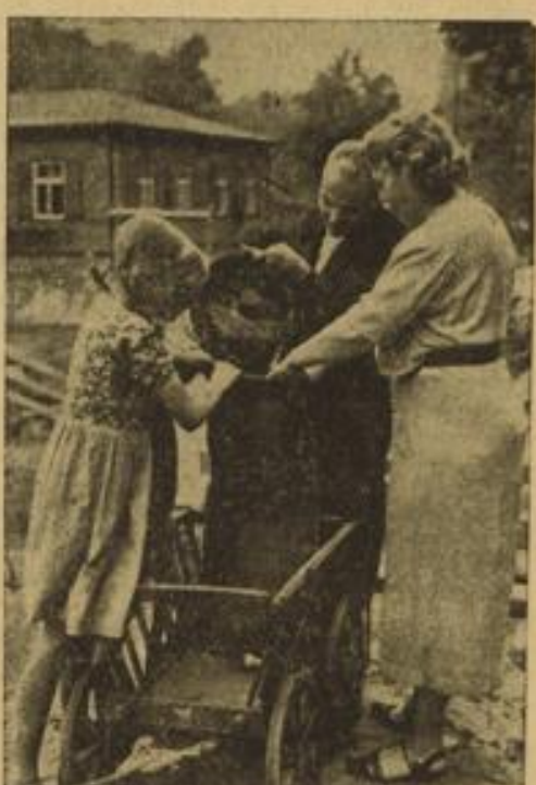
Alle helfen mit, um Sandsäcke für Luftschutzzwecke zu füllen.
