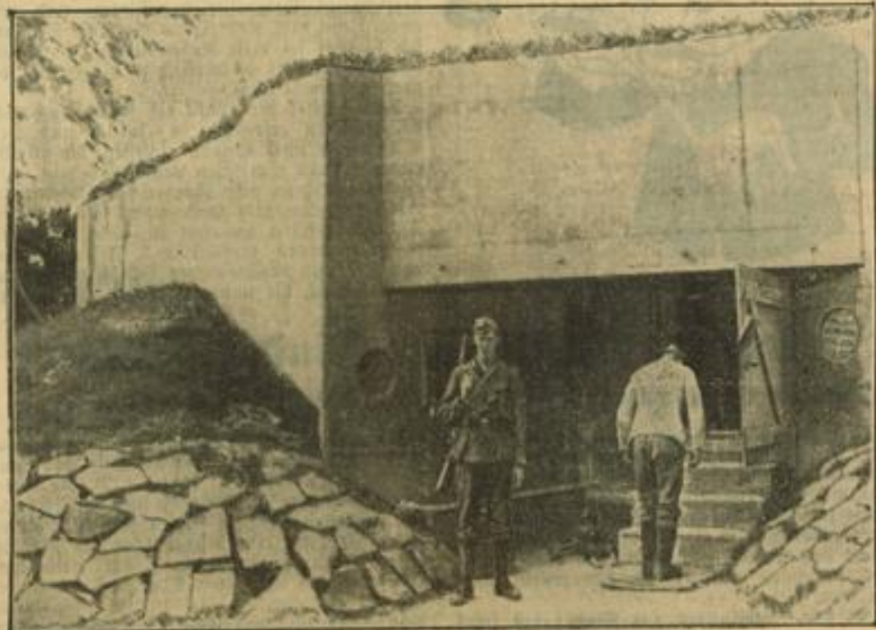
Vor einem deutschen Bunker im Westwall. Tag und Nacht stehen unsere Soldaten vor dem Westwall auf der Wacht, um jeden feindlichen Angriff abzuwehren. Hier steht man einen Posten vor dem Eingang zu einem Bunker. (PK Eckard, Scherl-Bilderdienst-M.)
