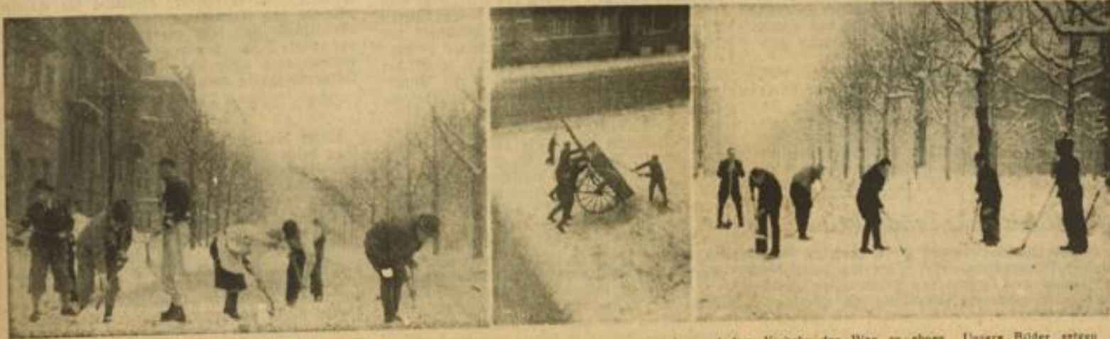
In allen Stadtteilen waren die Schneeschipper am letzten Wochenende dabei, die Straßen rein zu machen und dem Verkehr den Weg zu ebnen. Unsere Bilder zeigen die Schneeschipper in der Otto-Beck-Straße, die besonders geschäftig ausfiel und die Angestellte eines Unternehmens in der Augusta-Anlage, die gemeinsam ein Werk leisteten...
