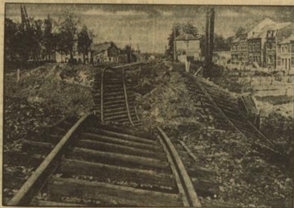
Zerstörte Eisenbahnbrücke in Bastogne.
