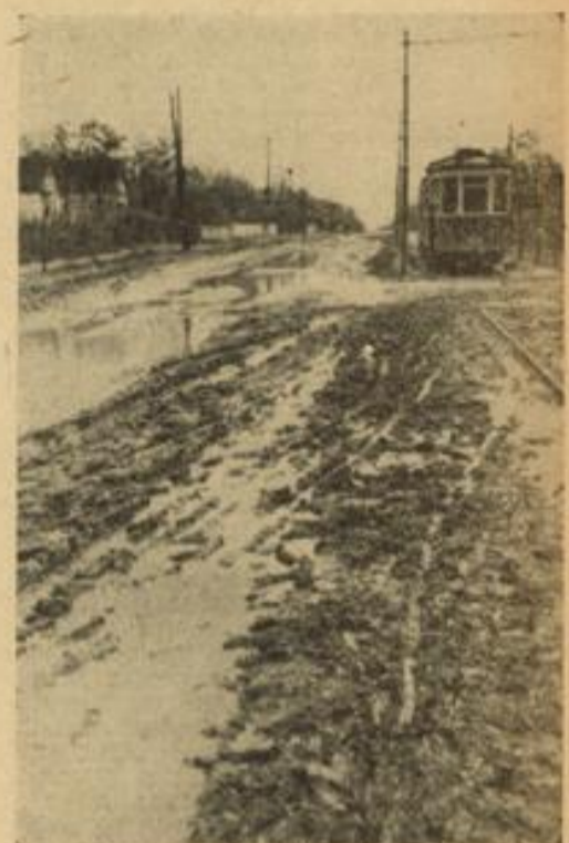
Straßen erster Ordnung im „Arbeiterparadies“ Diese Straße beispielsweise verbindet einen bekannten Kurort der Sowjets mit einer Großstadt (PK-Ausf.: Kriegsbericht Neuberger-Atl.)
