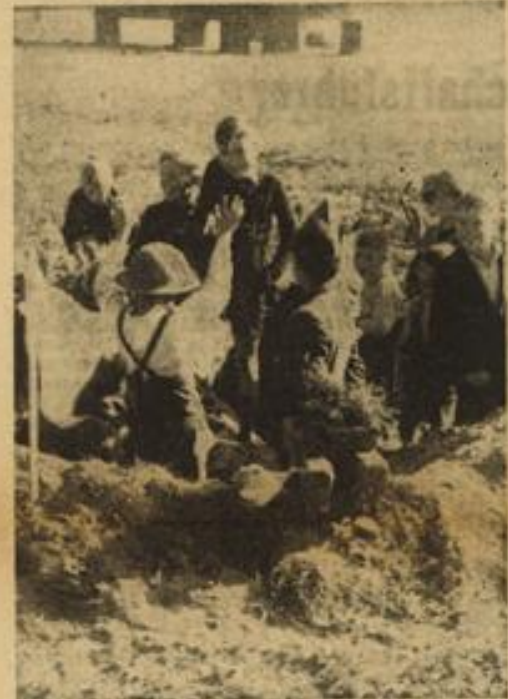
Ein „Tommy“ übergibt seinen am Rhein gebauenen Bunker.
