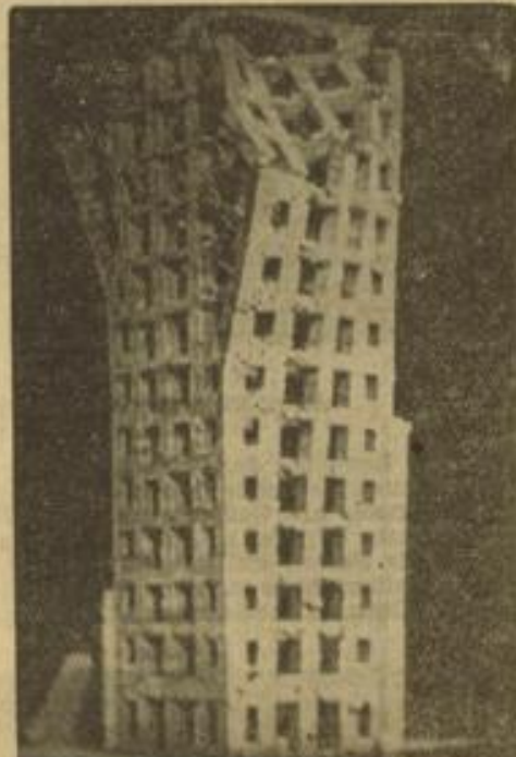
So wirkt ein Erdbeben auf Hochbauten. Das ist keine Spielerei, daß man hier Modellhäusern aufgebaut hat, um sie durch eine Bewegung des Modelltisches zu zerstören. Im Gegenteil! Es ist eine ernste Sache, denn durch die Zeitlupenaufnahmen, wie sie hier dem Ufa-Kulturfilm „Erdbeben und Vulkane“ entnommen sind, kann man genau studieren, wie Erderschütterungen auf Bauten einwirken und dadurch die Bauweise wie die Baustoffe so wählen, daß in erdbebengefährdeten Gebieten eine gewisse Katastrophensicherheit erreicht wird.
